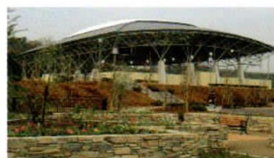
八ヶ池公園龍翔ドーム
